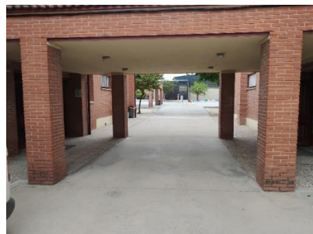
Entrada patio debajo del túnel (derecha e izquierda)
